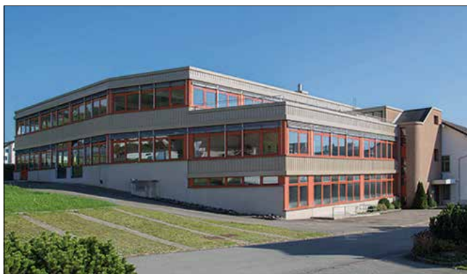
Neben neuen Schulungsräumen erwartet die Studierenden eine grosse Sonnenterrasse
